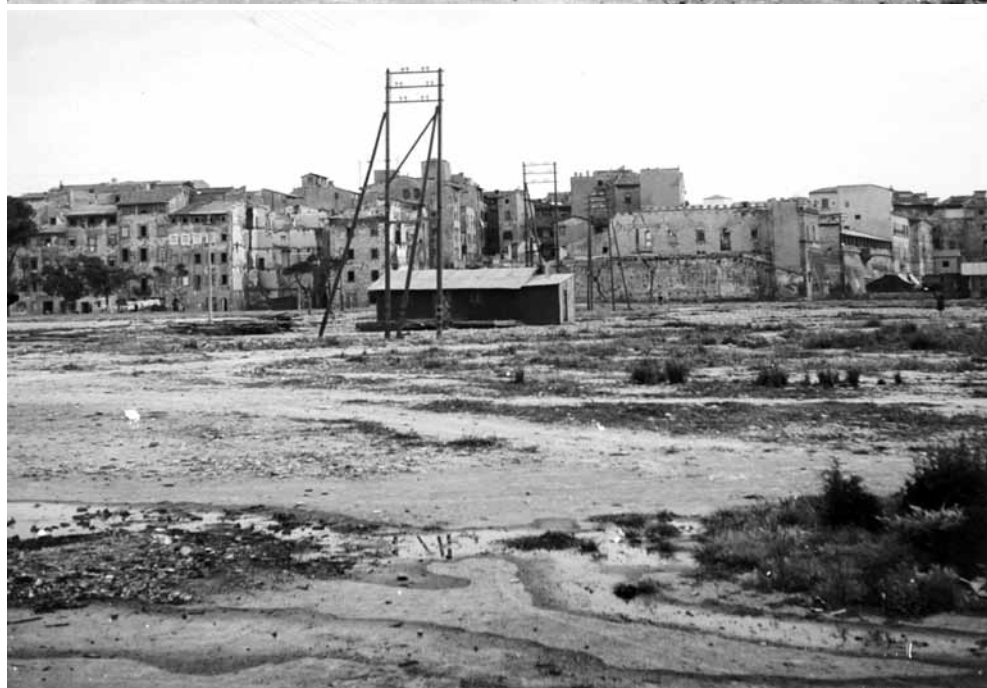
figg. 2, 3 - Area prospettante la Darsena vecchia, chiusa tra il Palazzo del Governo e della Questura e via Fiume. Zona interessata dagli sventramenti di epoca fascista e dai bombardamenti della Seconda guerra mondiale (foto di Bruno Miniati, ARCHIVIO GIOVANNI SALGHETTI-DRIO- LI DI VOLTERRA, BIBLIOTECA GUARNACCI-VOLTERRA, Progetti e atti relativi , n. 14)
