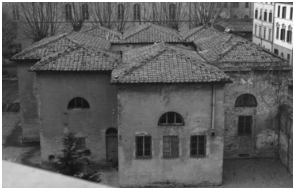
Fig. 2 - L' Asilo "Grabau" visto dall'istituto Tecnico Industriale
