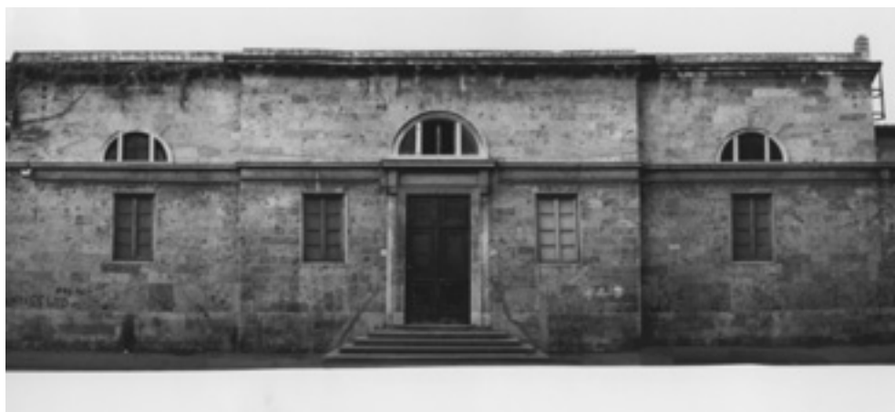
Fig. 1 - L’asilo infantile “Carlo Grabau”, 1863-65. Il prospetto principale su via Galilei
